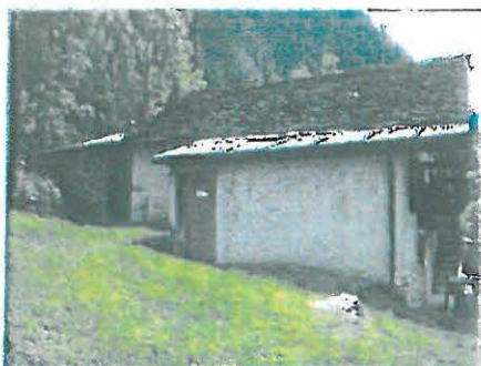
Facciata nord - corpo annesso eventualmente da demolire
